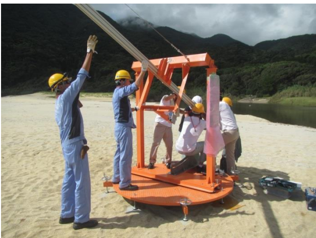
図5 ランチャー上段部の設置作業
