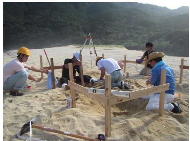
図4 ランチャー土台用の土木工事 (杭打ち, 水準揃え)
