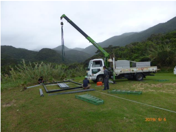
図3 プレハブ建設工事
