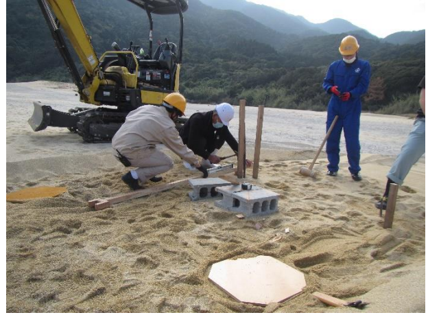
図4 ランチャー土台用の土木工事
