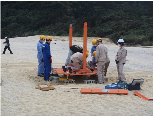
図5 ランチャーの組立て作業
