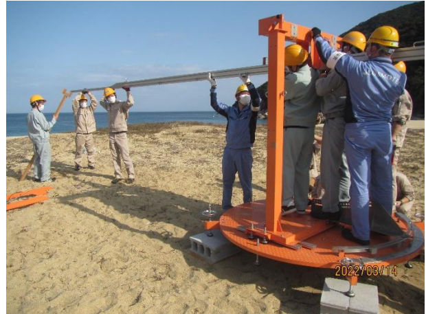
図7 ランチャーの組立て作業2
