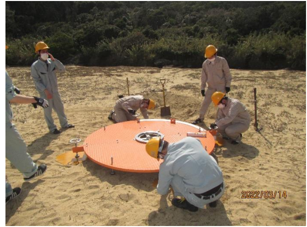
図5 ランチャーの土台据付作業
