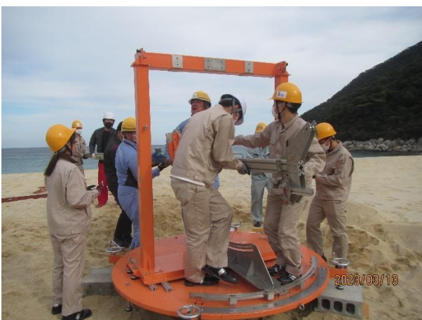
図6 ランチャーの組立て作業
