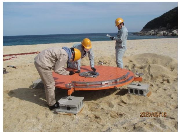
図5 ランチャーの土台据付作業
