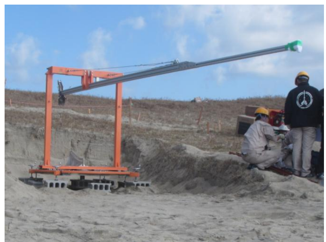
(d) ランチャー設置作業
