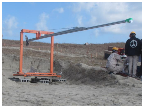
(d) ランチャー設置作業
