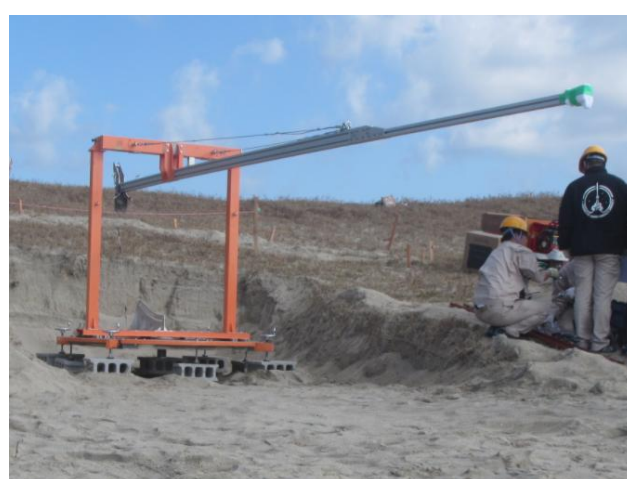
(d) ランチャー設置作業
