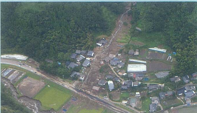
사진-3 태풍14호에 의한 다루미즈시의 토사재해
